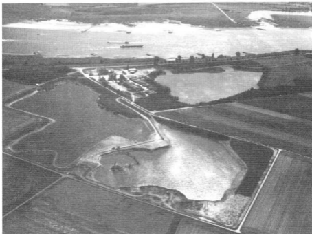
Foto: F. Schewe, Thermo-Inspekt GmbH, 4224 Hünxe (UrhG § 13).
